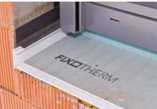
Das System bildet eine dichte Wanne am Fenster und wird wie gewohnt in die Mauer versetzt. Mit Hilfe des verklebten Einputzwinkels kann ordentlich verputzt werden.
